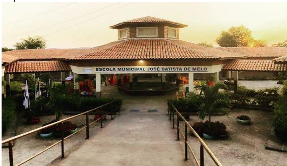
Figura 1 – Fachada da Escola Municipal José Batista de Melo localizada no município de Gravatá-PE.
